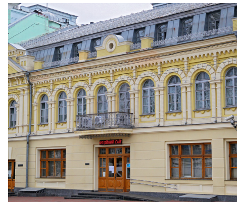
Будинок Назарія Сухоти, 1804 р., арх. А. Меленський. 1876-1878 рр. – реконструкція під влаштування 3-ої чоловічої гімназії, арх. А. Шілле, військовий інженер В. Прохоров. Конtrakтова пл., 12/8, ріг вул. Покровської
